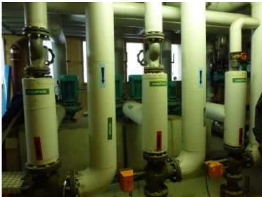
Départs des réseaux en chaufferie
